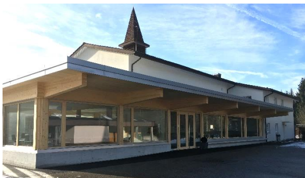
Die Quartierschule Mühlethal nach dem Umbau
