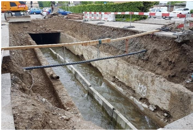
Sanierung Altachenbach, Bereich Rotfarbstrasse
