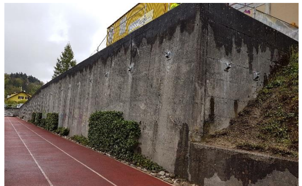
Die Stützmauer am Postweg wurde stabilisiert
