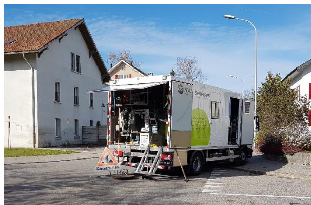
Die Kanalisationsanschlüsse sämtlicher Zofinger Liegenschaften werden in den kommenden Jahren systematisch erfasst
