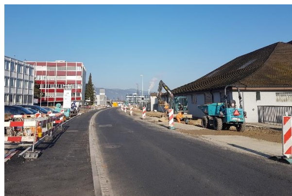
Belagssanierung Untere Brühlstrasse
