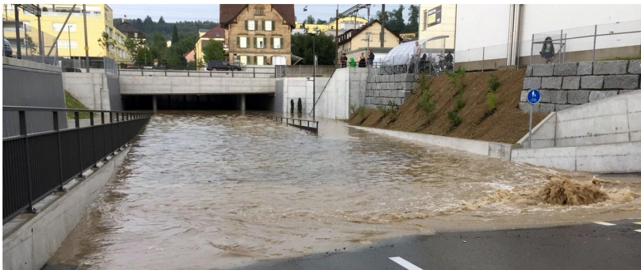
Die Wassermassen blockierten mehrere Unterführungen
