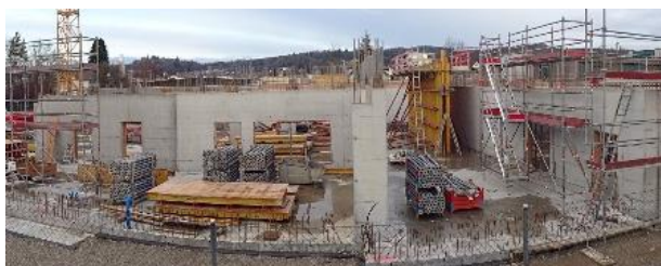
Quartierschulhaus BZZ im Rohbau
