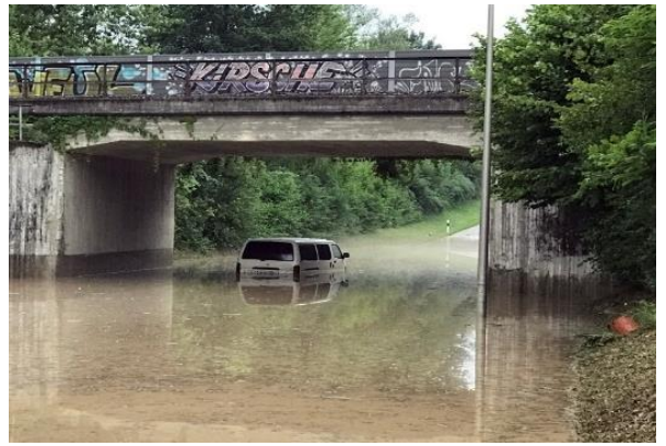
Das Unwetter hinterliess Sachschäden, glücklicherweise kamen keine Personen zu Schaden
