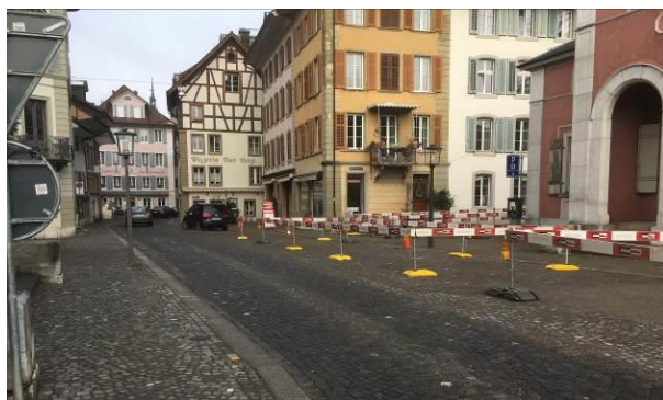
Oberer Stadteingang, Vordere Hauptgasse
