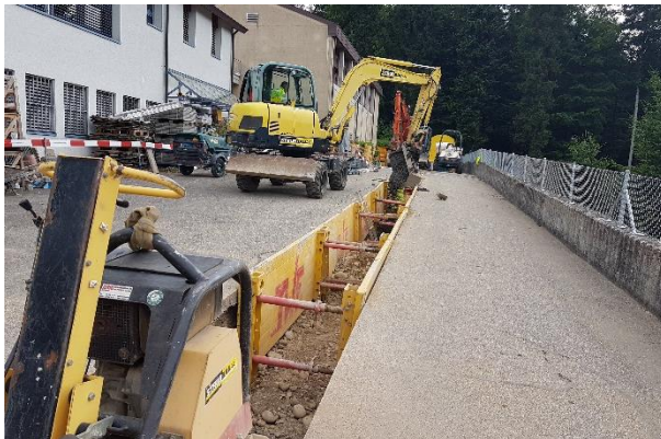
Sanierung der Kanalisation im Postweg, Ortsteil Mühlethal
