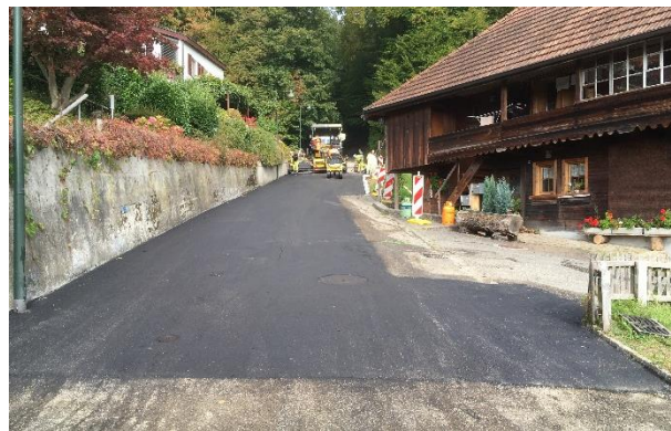
Haldenweg nach der Sanierung
