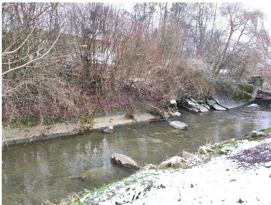
Abb. 8: Ufer- und Sohlsicherung unterhalb des bestehenden Wehres.
