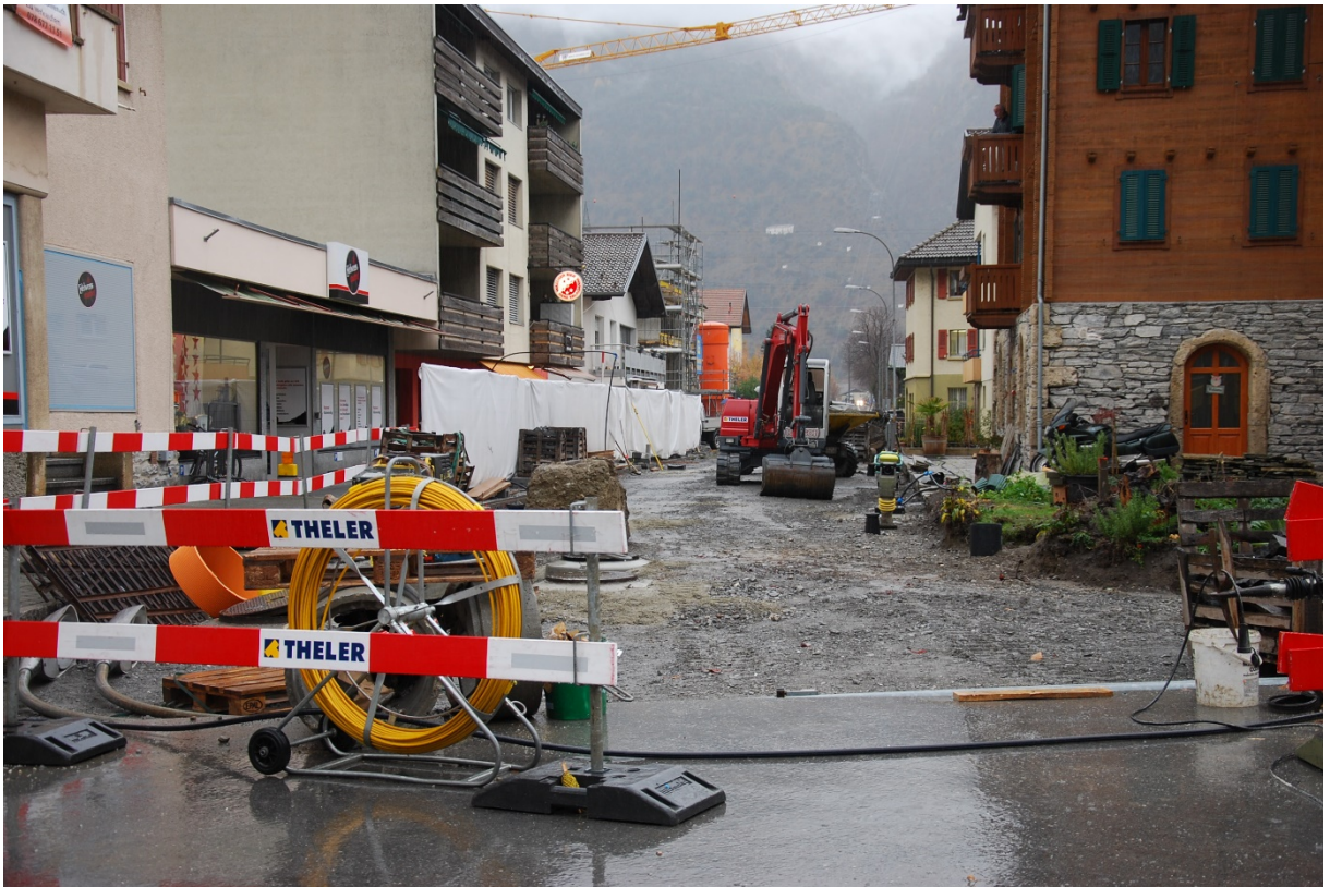
Baustelle Bahnhofstrasse Nord
