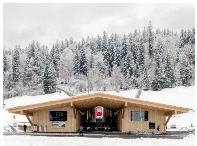
Neubau Talstation, Standseilbahn Unterwasser – Illtios, Toggengurg Bergbahnen, Früeweidstrasse 8, Unterwasser
