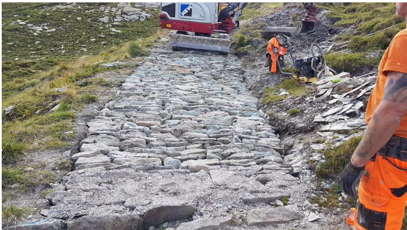
Die Trockenmauer-Spezialisten der Firma HEW AG bei der Sanierung der Pflasterung (Bild: NPB)
