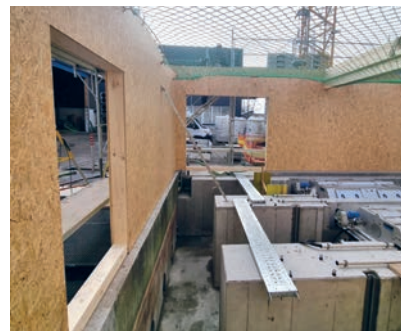
Einblick in den Rohbau
