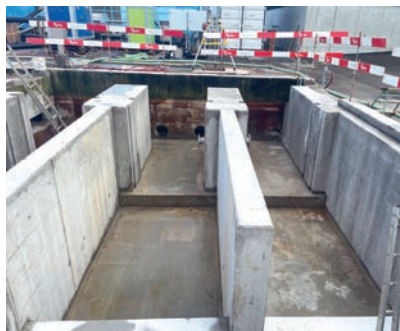
Vorbetonierter Kanal für die Trommelsiebe.
