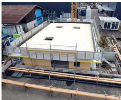
Rohbau der Maschinenhalle.
