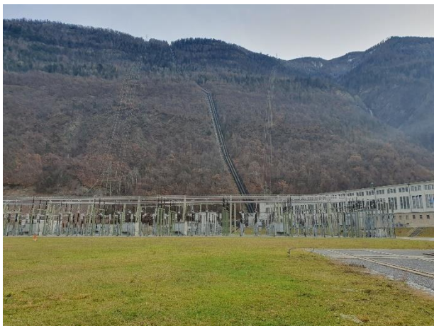
Photo 3 : Vue d'ensemble sur le coteau (2°58'2231 ; 1°11'1979)
