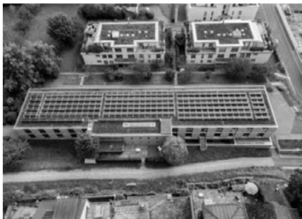
Photovoltaikanlage Altersheim Städtli
