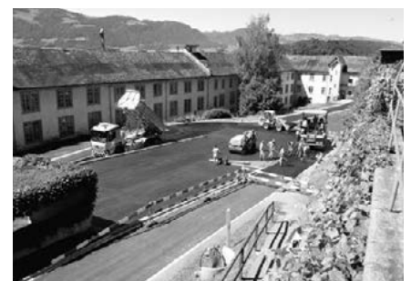
Belagsarbeiten zur Neuerschliessung im Bereich Seidenweberei/Altersheim Städtli
