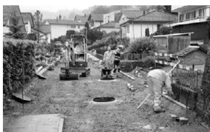
Randsteinsetzung an der Brauereistrasse
