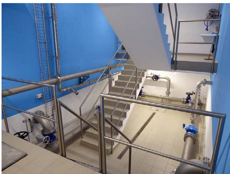
Innenansicht Reservoir Rüti
