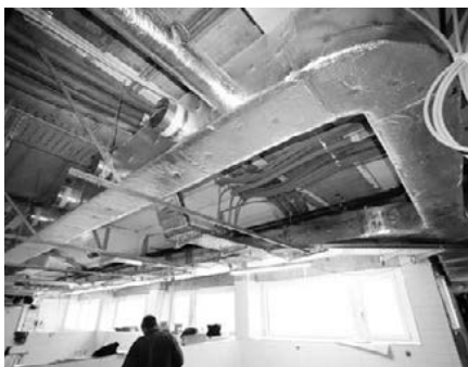
Sanierung Haustechnik Hochbau (B)
