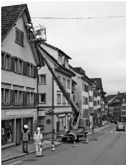
Installationsarbeiten für die neue Städtchenbeleuchtung
