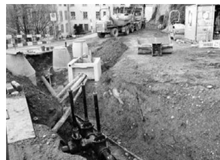
Neue Hydrantenleitung beim Seidenweberei-Areal
