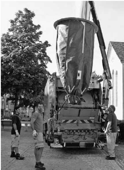
Hebung eines Unterflur-Sackbehälters mit Kran
