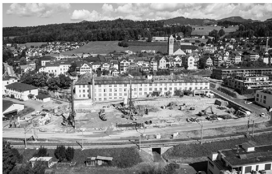
Baustelle «Im Seidenhof» Webereistrasse
