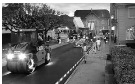
Deckbelageinbau an der Bahnhofstrasse
