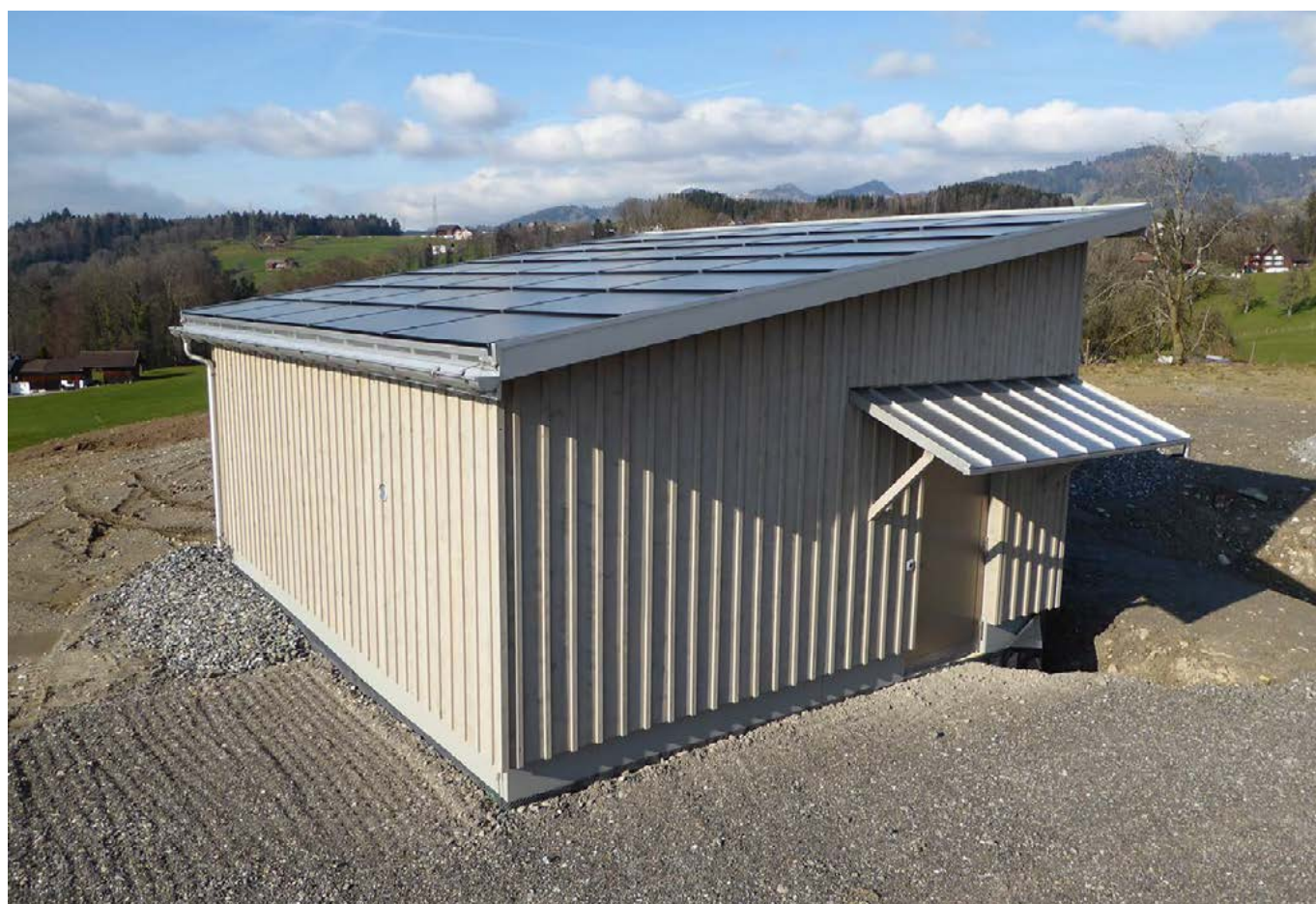
Reservoir Rüti mit Photovoltaikanlage auf dem Dach
