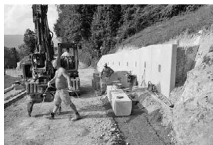
Versetzen der Natursteinblöcke im Bereich der neuen Ausweichstelle (Bergli)
