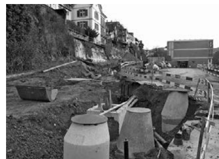
Neue Kanalisationsschächte hinter der Seidenweberei
