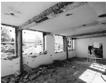
Abbrucharbeiten Hochbau (B)
