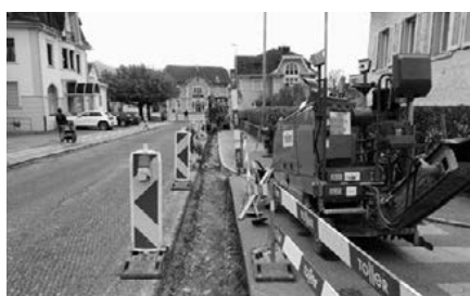
Belagssanierung sowie Optimierung der Strassenentwässerung an der Bahnhofstrasse
