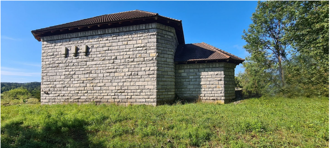
Abbildung 13: Caissonbrunnen nach Umbau (Fotomontage rückgebauter Erdwall, neue Verbindungsleitung im Boden)
