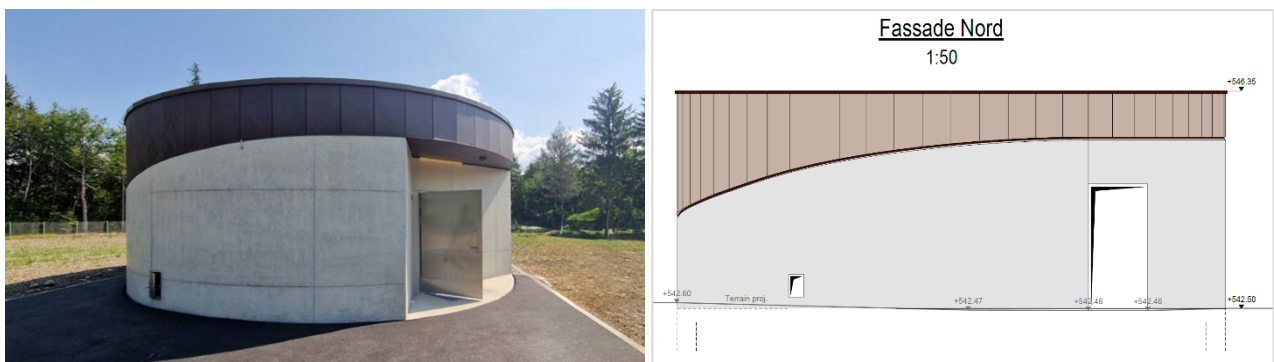
Abbildung 8: Foto: Fassade GWF Oberer Au, Uttigen / Plan: Ansicht Nordfassade (gemäss Beilage 1423-0/016)
