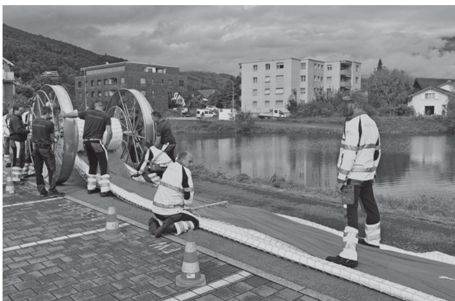
Die Elemente des mobilen Hochwasserschutzsystems werden miteinander verbunden, mit Wasser gefüllt und bilden einen Schutzdamm.
