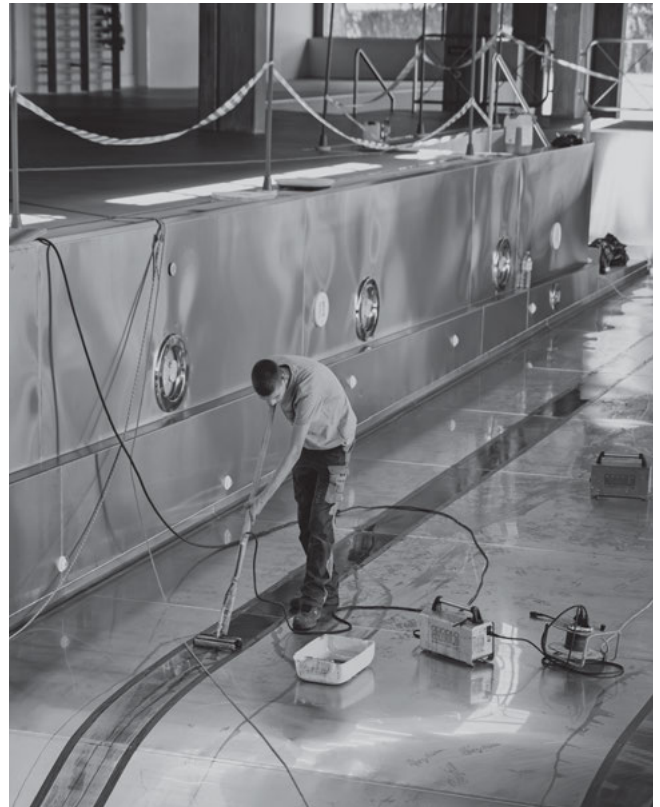
Die Wände der Chromstahlwannen müssen von Hand gereinigt werden (Bild links). Ein Mitarbeiter eines beauftragten Fachunternehmens eloxiert die Linien, welche die Schwimmbahnen markieren (Bild rechts).
