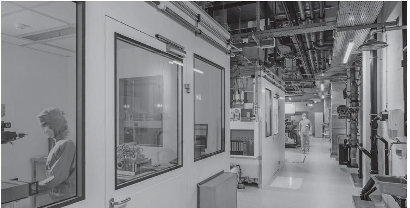
Ein Reinraum ist ein speziell konzipierter Raum, in dem sich Temperatur, Druck sowie Feuchtigkeit und Reinheit der Luft genau regulieren lassen.
