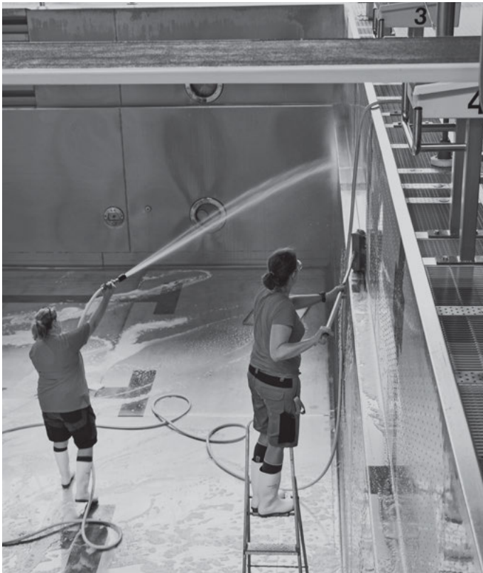
Die Wände der Chromstahlwannen müssen von Hand gereinigt werden (Bild links). Ein Mitarbeiter eines beauftragten Fachunternehmens eloxiert die Linien, welche die Schwimmbahnen markieren (Bild rechts).
