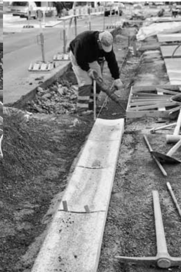
Die Rinnsteine werden zu einem Ganzen zusammengefügt.
