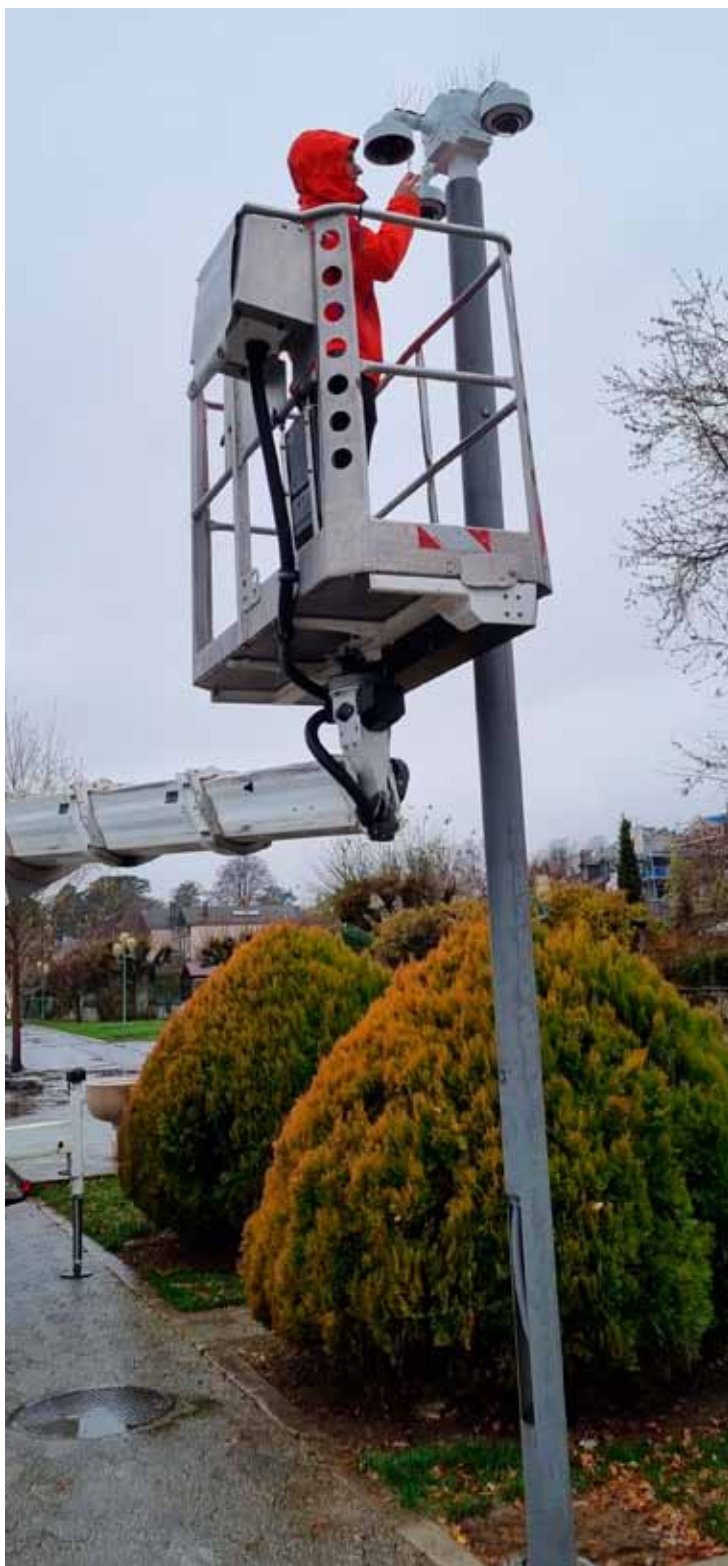
Pose de caméras sur les quais.
