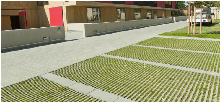
Bild 5.5 Die Parkfelder sollen mit Drainsteinen ausgestaltet werden.
