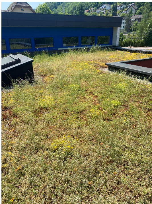
Abbildung 3: Die Dachbegrünung auf dem Schulareal.
