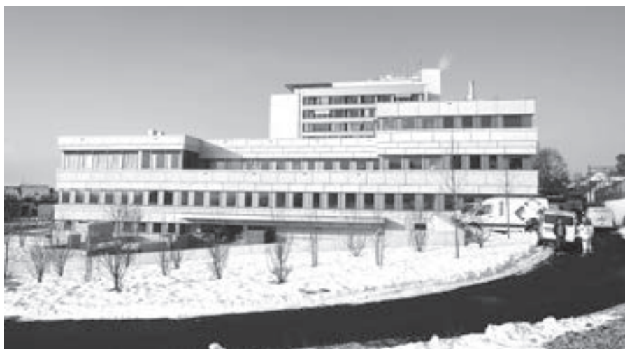
Aussenansicht Neubau (D)
