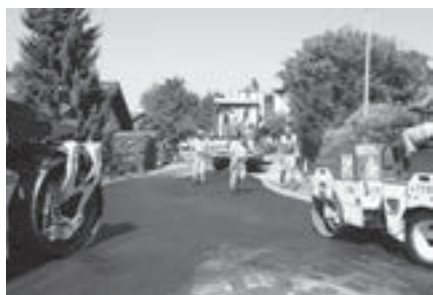
Belagsarbeiten bei der Tönierstrasse/Teil Niederwiesstrasse
