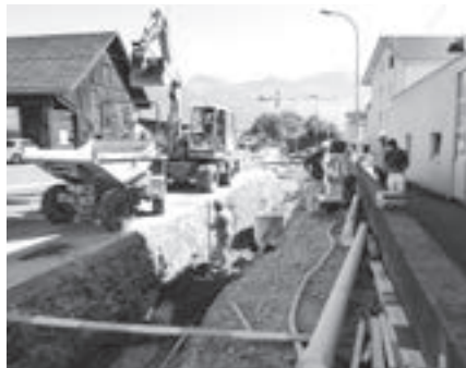
Grabarbeiten für Werkleitungen in der Gasterstrasse
