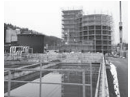
Faulturm vor der Fertigstellung
