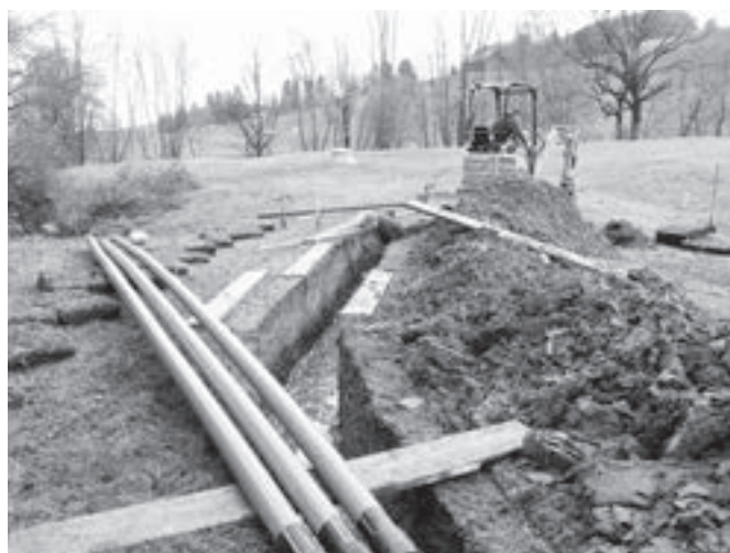
Quellschacht-Verbindungsleitungen vor dem Einbau
