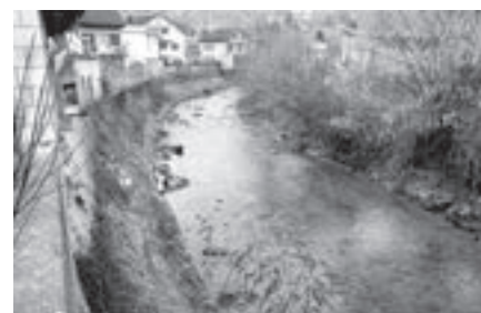
Harte Uferverbauung beim Aabach
