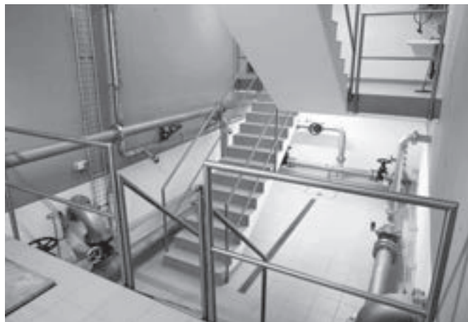
Innenansicht Reservoir Rüti
