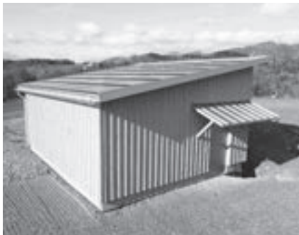
Photovoltaik-Anlage auf dem Reservoir Rüti
