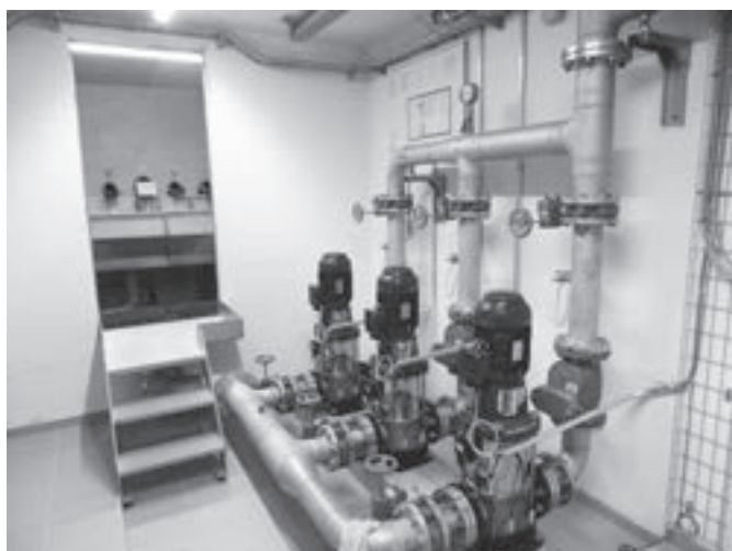
Neuer Pumpenschacht (links) sowie Quellschächte auf dem Ricken
