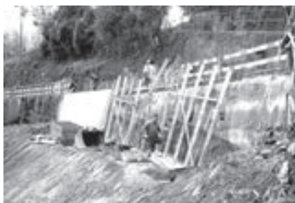
Talseitige Mauerverstärkung im Bereich Bergli
