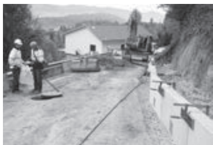
Bergseitige verankerte Elementplatten-Mauer im Rutschhang Leutschen
