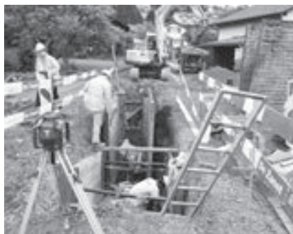
Vorbereitungsarbeiten für die Kanalisationsleitung im Tönierweg
