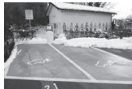
Elektro-Tankstellen auf dem Parkplatz Herrenacker
