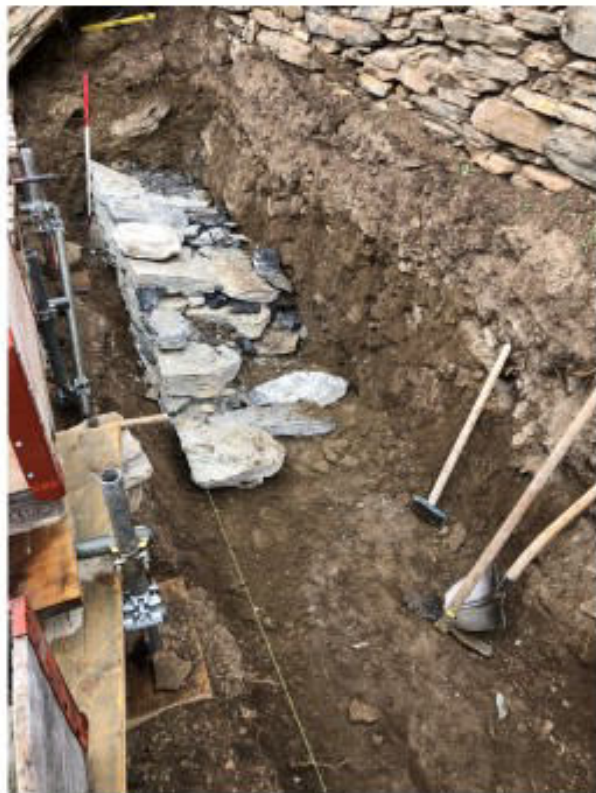
Fundament 0.5m im Boden
