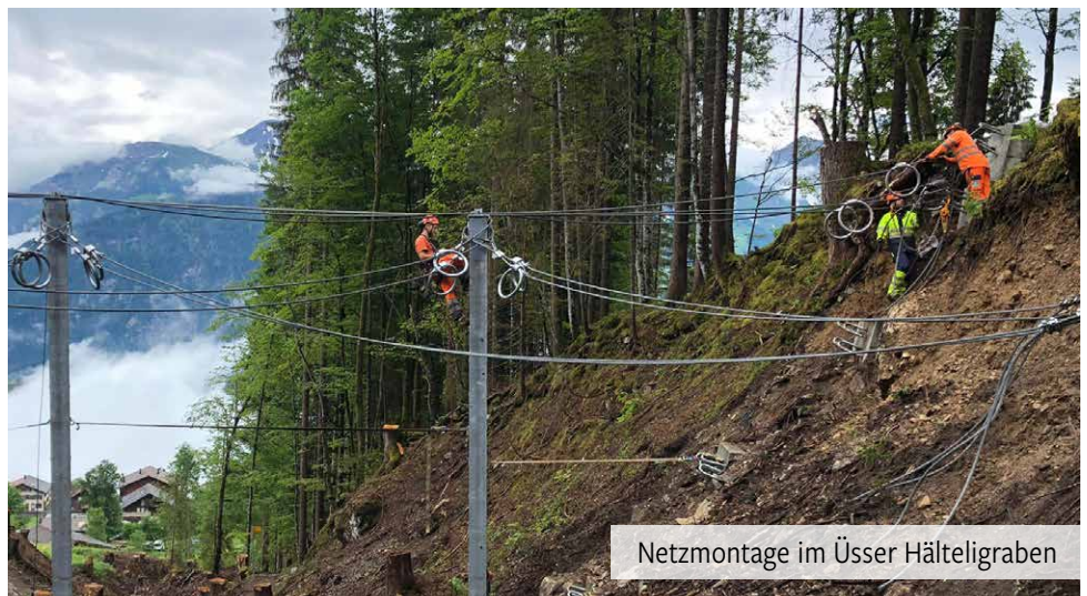
Einbau Netzverankerungen
