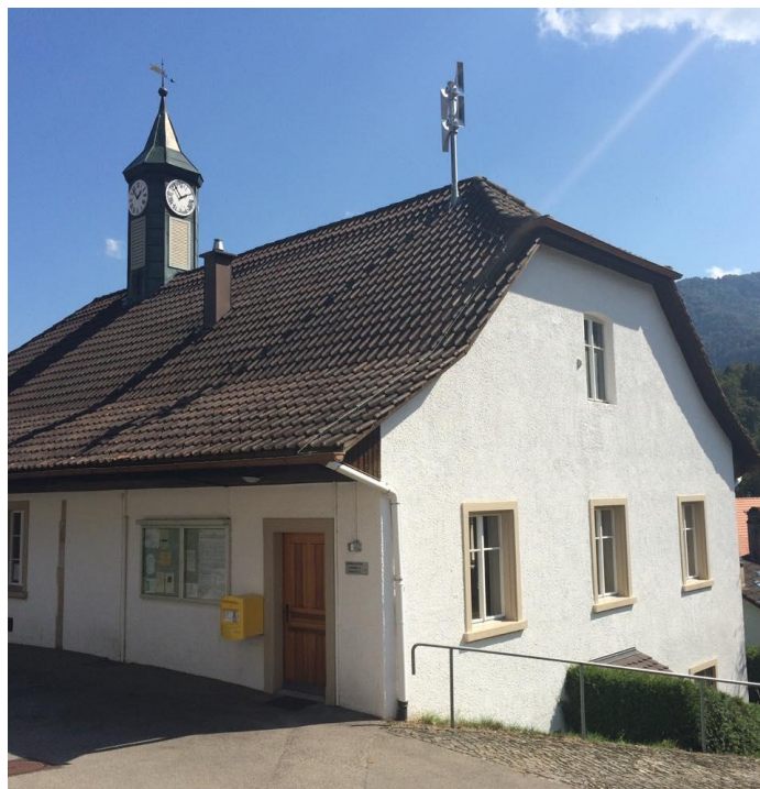
Bâtiment communal / école enfantine
