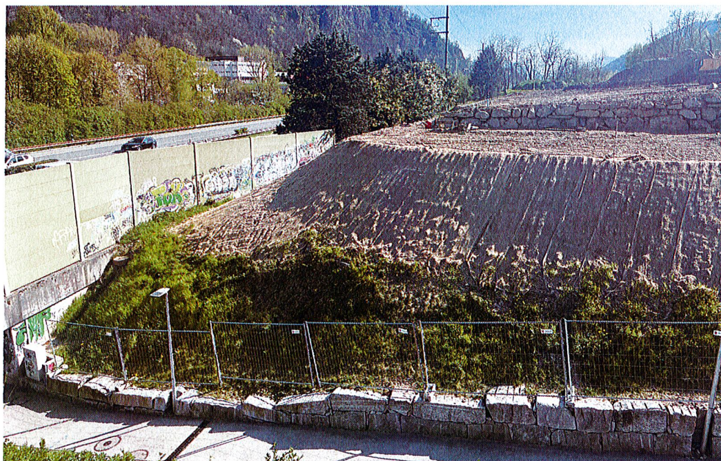
Foto rilevato terreno nell'estate 2025 durante i lavori preliminari del Parco Solare
