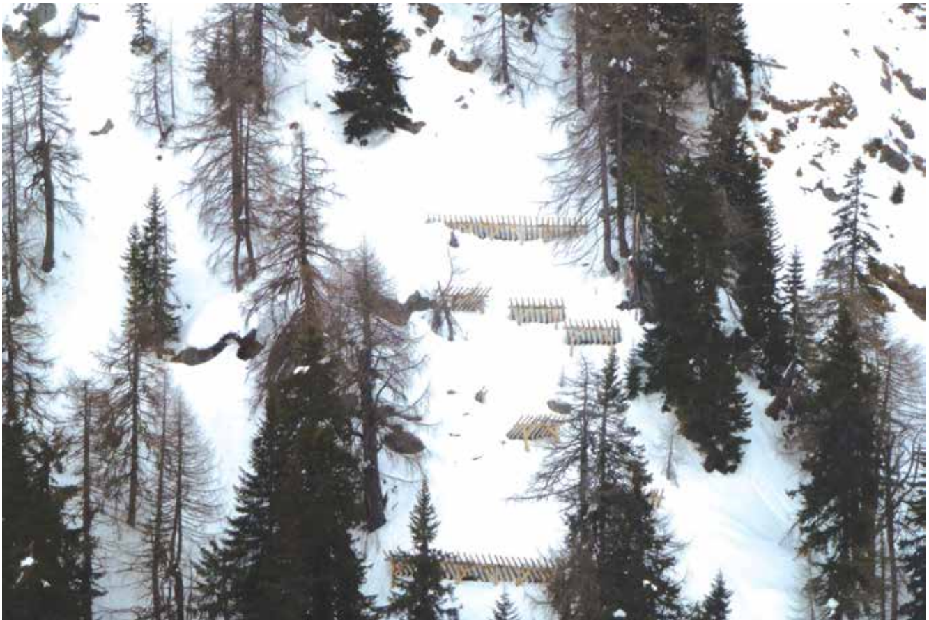
Premunizione valangaria "Riazzöö", Prato-Sornico.
