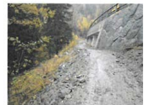
Baustrasse wird nicht rückgebaut
