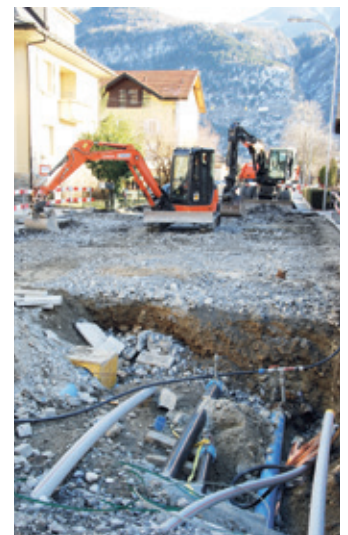
Strassenquerschnitt Bahnhofstrasse Nord mit eingelegter Infrastruktur
