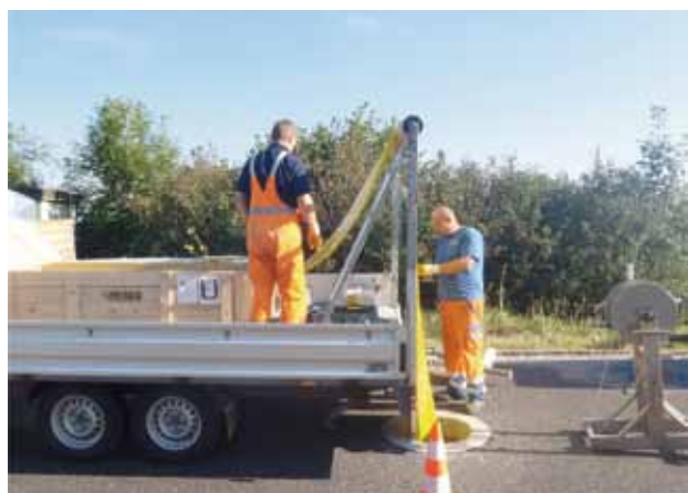
Schlaucheinzug in die Kanalisationsleitung
