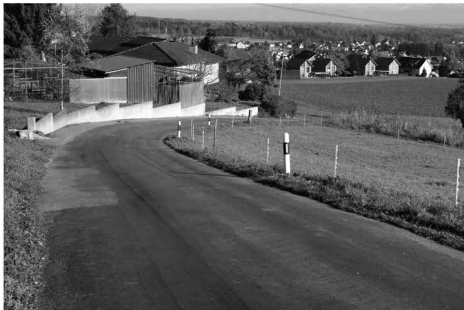
Die Ottenbergstrasse, hier mit Blick Richtung Berg, soll saniert werden.
