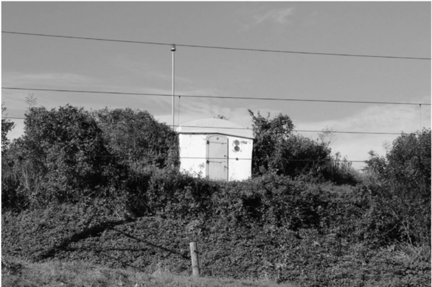
Das Reservoir Mauren aus den Jahren um 1930 soll abgebrochen werden.
