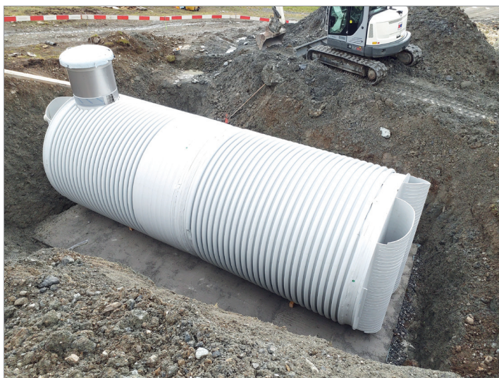
Batschigl da regulaziun (ils purtrets muossan il batschigl installà dal 2021 sü Val Ruschna, Scuol)
