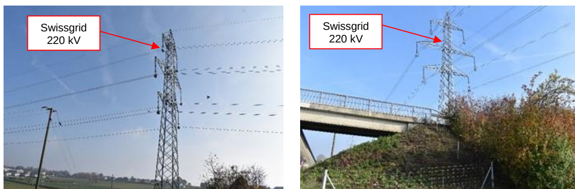
Figure 4 : Photos de la ligne Swissgrid 220 kV – Source : Groupement NIP, prises de vue 11.11.2021
