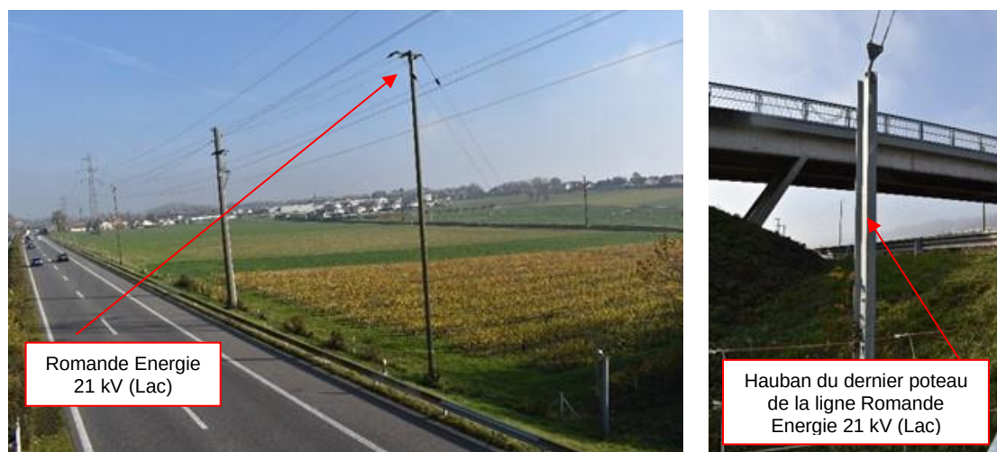
Figure 10 : Photos de la ligne Romande Energie 21 kV côté Lac – Source : Groupement NIP, prises de vue 11.11.2021
