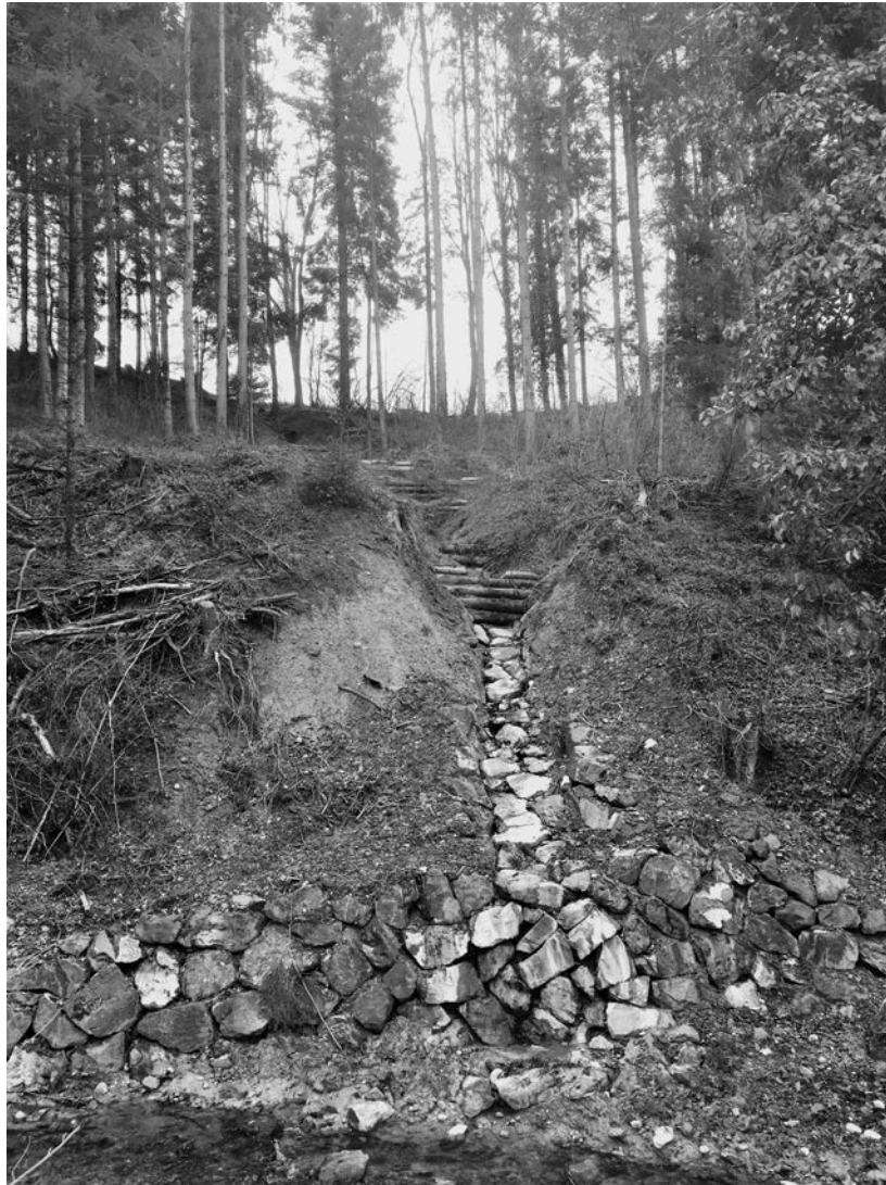
Sanierte Försterschwelle in Neukirch an der Thur
