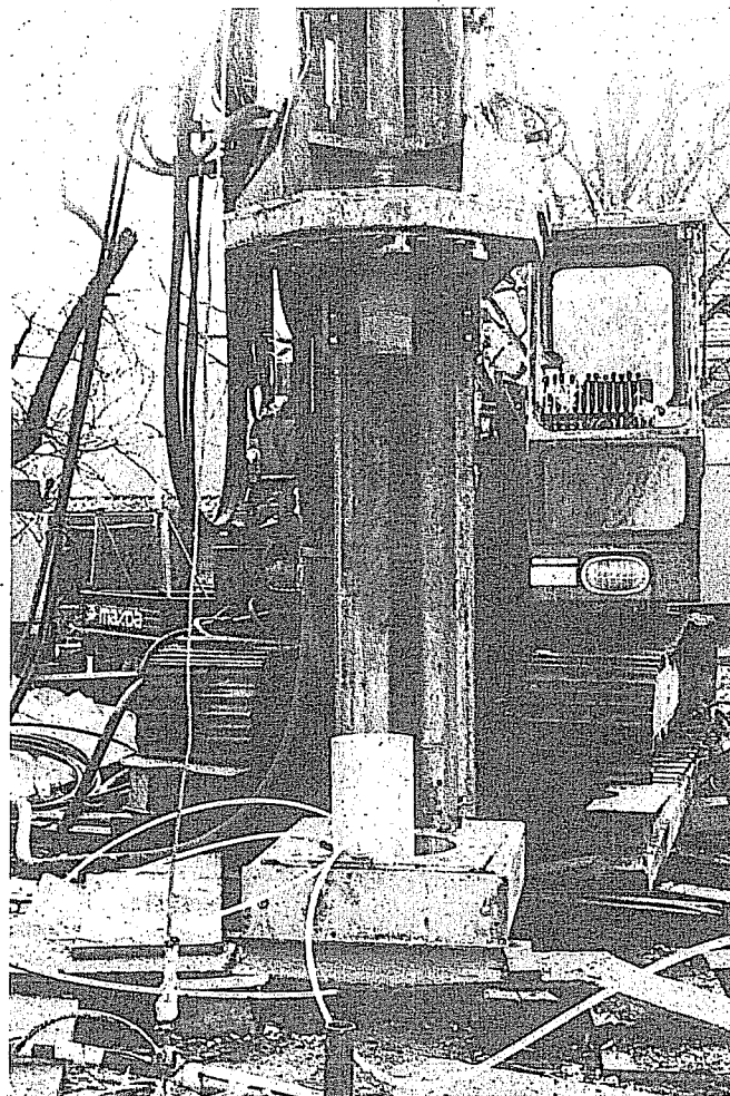
Bohrung für Grundwasserbrunnen
