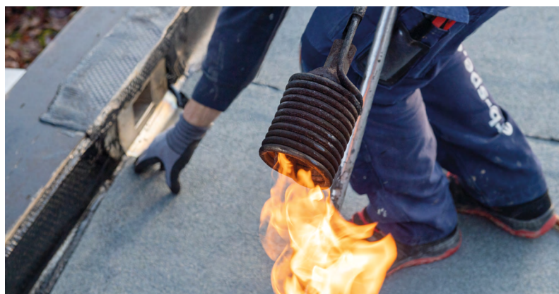
Neben den Spenglerarbeiten zählen Flachdacharbeiten zu den zentralen Geschäftsfeldern.
