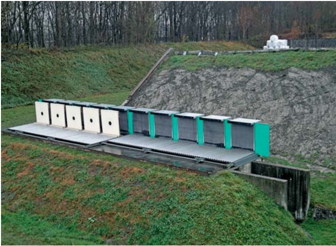
Die neuen künstlichen Kugelfangsysteme mit dem sanierten Erdwall.
