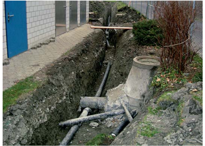
Links: die neu geführte Meteorwasserleitung.
