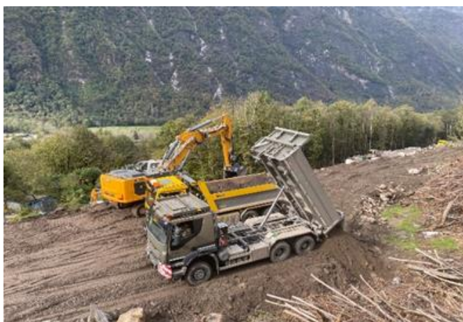
Lavori in corso alla deponia 1 di Sorte, Foto Giudicetti e Baumann
