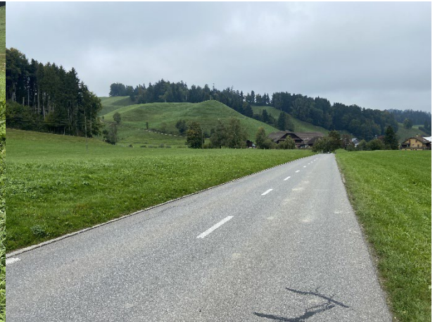
Überblick Hübelistrasse, anthropogene Böschung, vom 02.10.25
