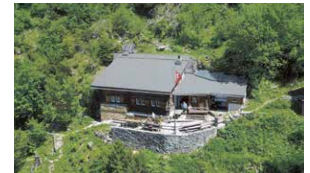
Enderlinhütte vor dem Umbau 2020: So präsentierte sich die Enderlinhütte mit der angebauten Brunnenhütte und dem Waschraum vor der erneuten Erweiterung.
