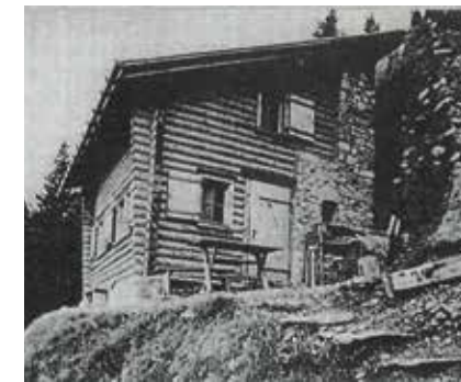
Ersatzbau und Erweiterung Enderlinhütte: Im Jahr 1954 wurde die Enderlinhütte neu aufgebaut und zwanzig Jahre später erweitert. Für diesen Bau wurde eine Seilbahn erstellt.
