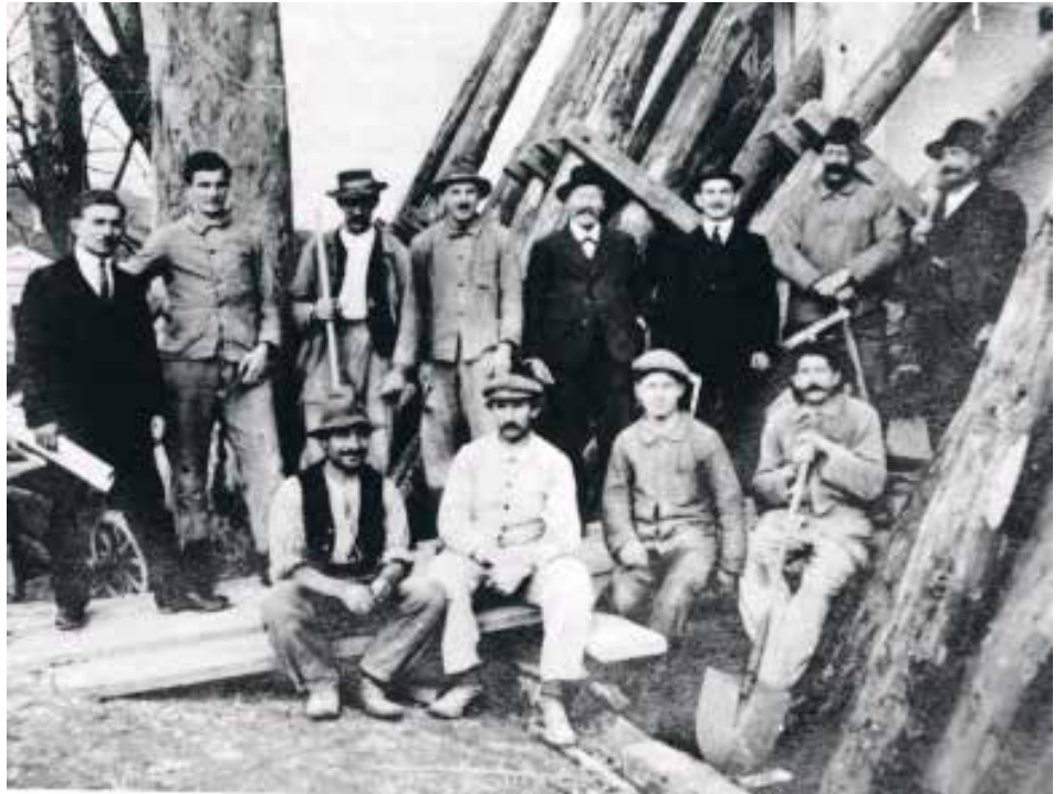
Der Kirchturm neigt sich. J. Lenz und Söhne, nebst Gesellen lösen dieses Problem durch Verstärkung der Fundamente (1922)
