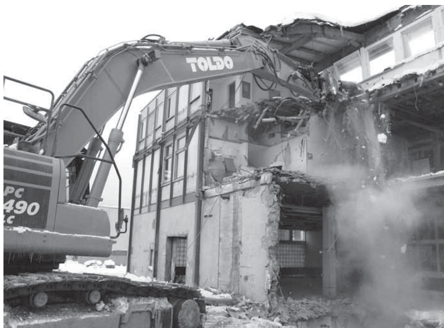
Der «alten» Post geht es an den Kragen: Die verschiedenen Baumaterialien werden noch auf der Abbruchstelle sortiert.
