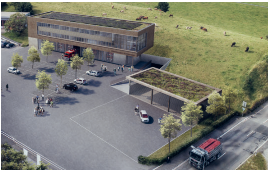
■ Der Baubeginn des Neubaus Gemeindehaus und Feuerwehrdepot ist am 3. Mai 2021.
