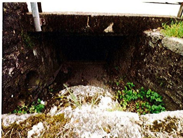
Tratto intubato del torrente Mator dell'Uccello
