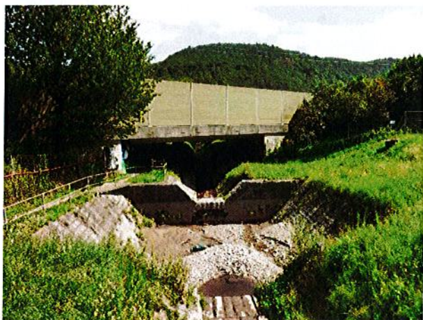
Camera di ritenuta a monte del sottopasso autostradale
