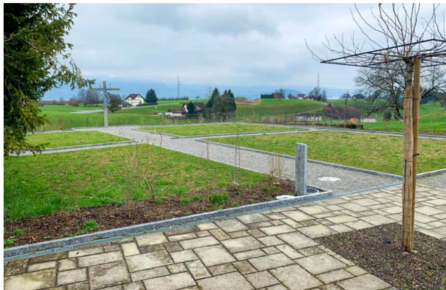
■ Die Sanierung des Friedhofs Gommiswald konnte erfolgreich abgeschlossen werden.
