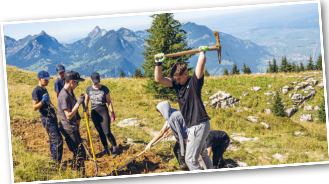
Fundament für eine Kuhtränke.
