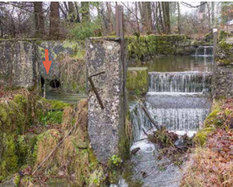
Sägeweiler und Stauwehr, gespiesen vom Feissibach, sind die letzten Zeugen, welche heute noch auf die ab dem Jahr 1929 mit Wasserkraft betriebene «neue» Säge hinweisen. Links der Zufluss vom Schwandbach (Pfeil).
