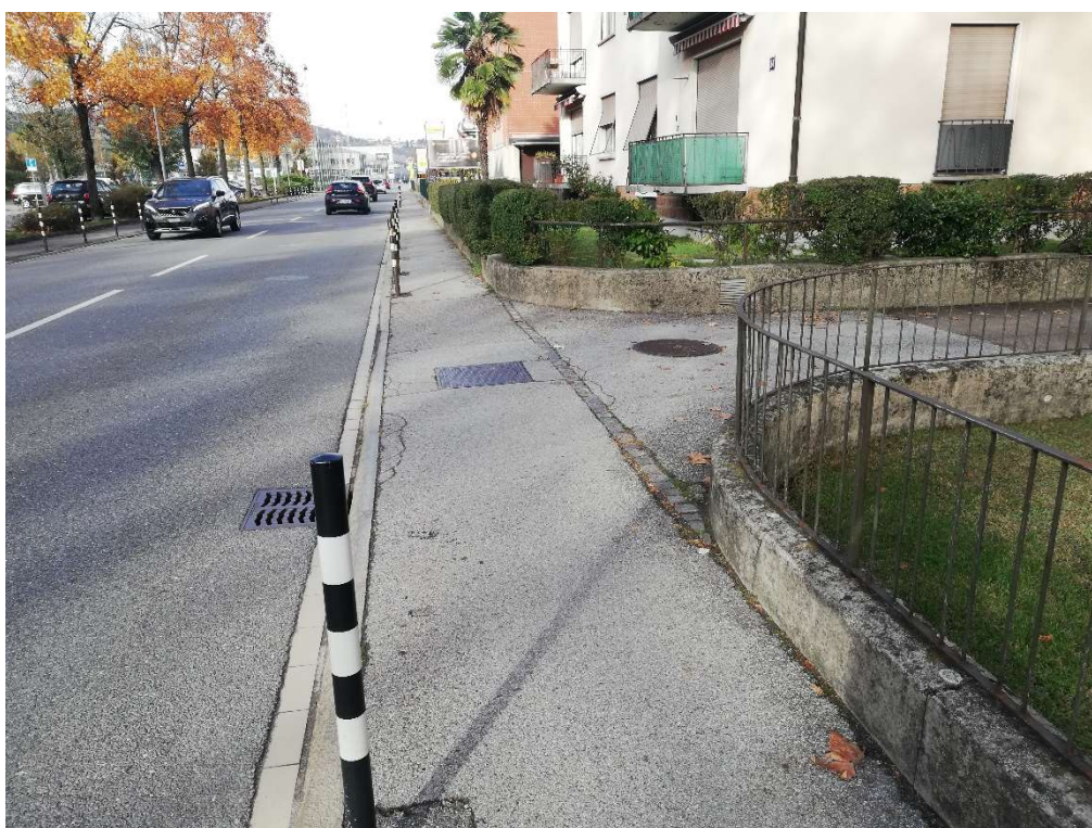
Marciapiede nord – corsia direzione Chiasso-Balerna
