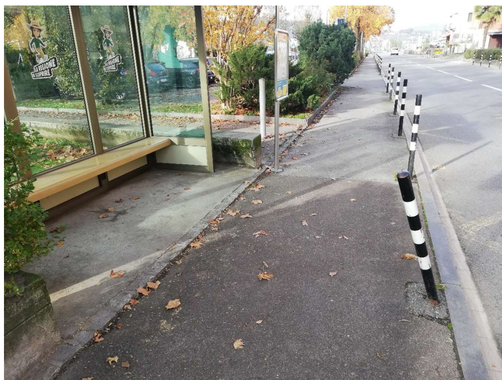
Marciapiede sud – Corsia direzione Balerna-Chiasso
