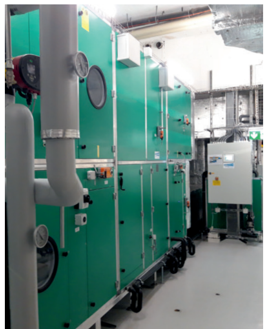
Neue Lüftungsanlage
