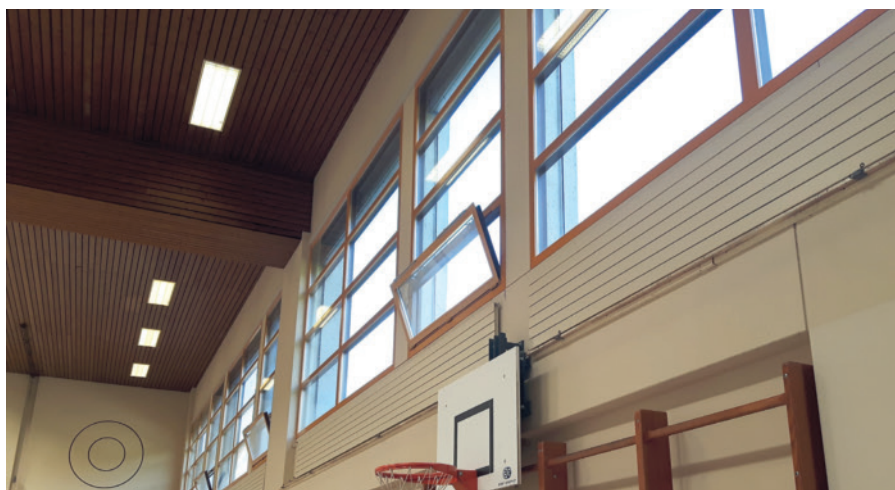
Heutige Fensterfront mit Kippfensterflügeln in Turnhalle
