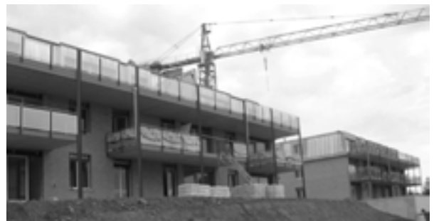
Nouveau quartier en construction « Aux Prés du Gaud »
