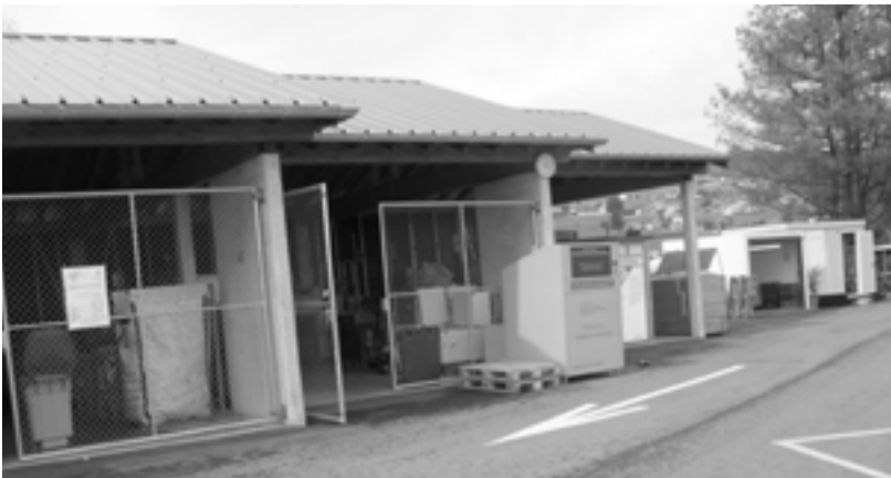
Nouvelle déchetterie de Rolle, inaugurée le 7 juin 2008
