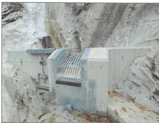
Foto 9: Opera di presa ultimata
