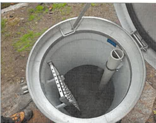
Foto 4: Primo riempimento camera (09.10.2024)
