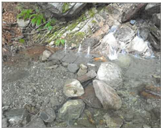
Foto 1: Presa provvisoria a 820 m s.m.
