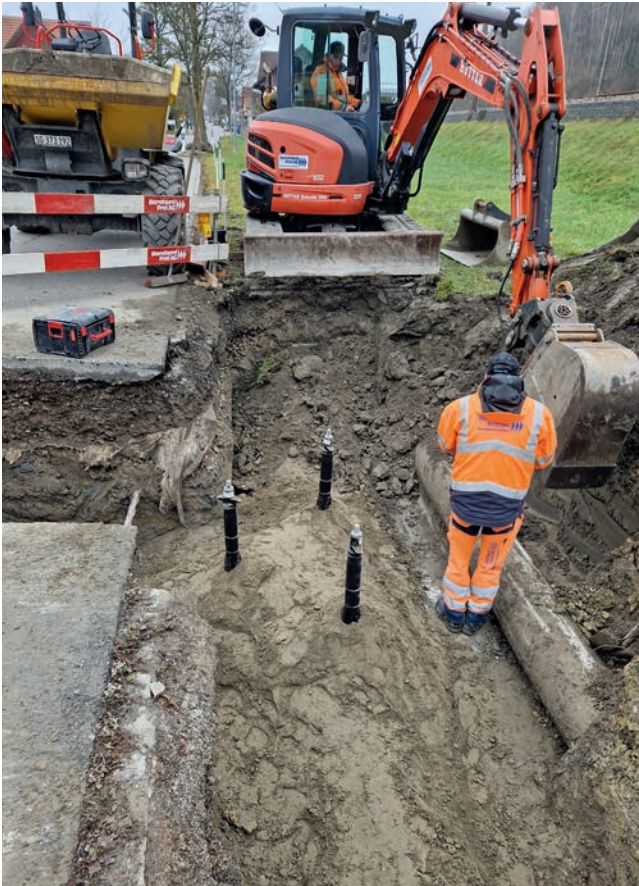
Wasserleitung, Anbindung Nebengraben West / Kurt Metzlerstrasse mittels 3er-Schieberkombination.
