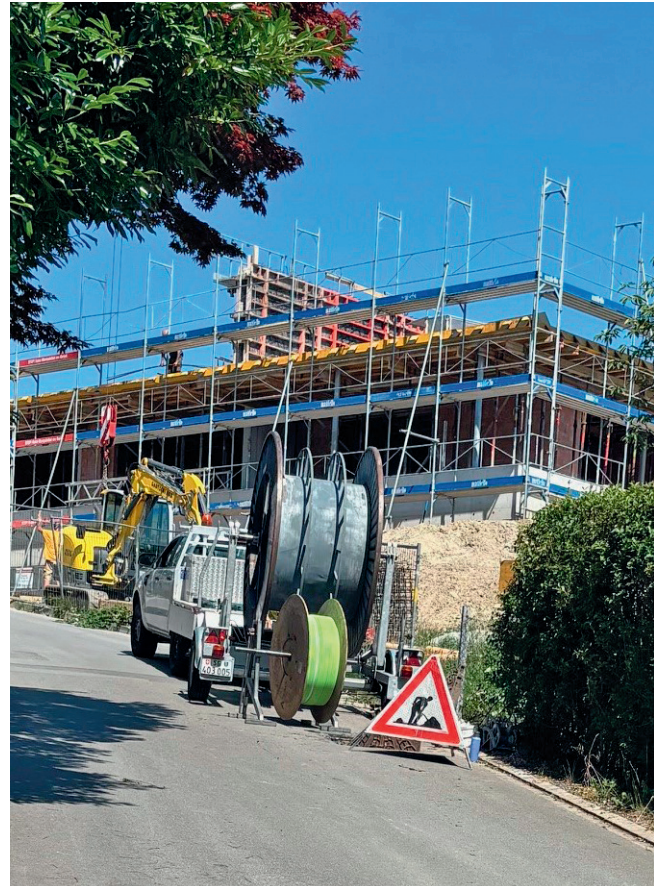
Netzverstärkung EW Dietrichshaldenstrasse.
