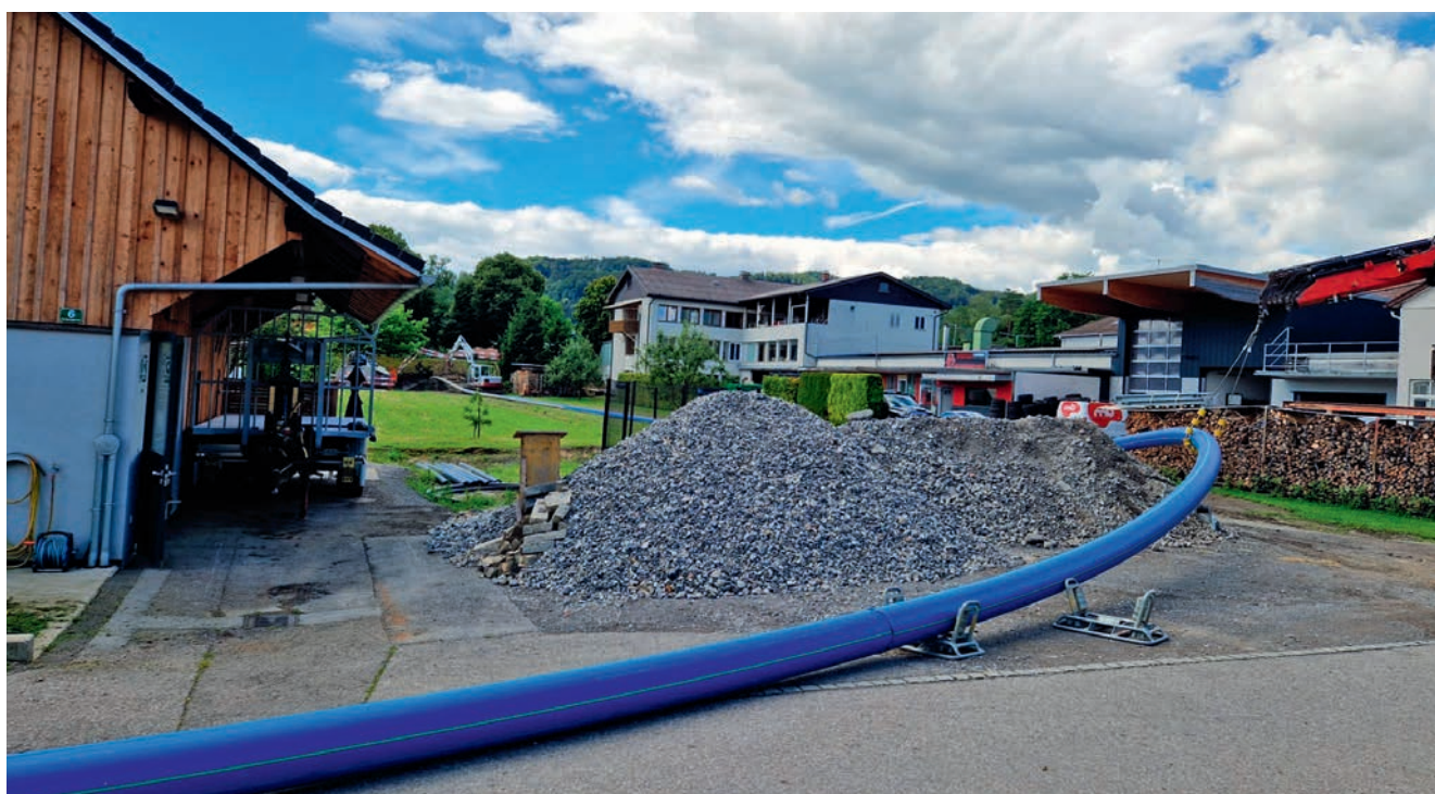
Einzug der neuen Wasser-Leitung Höchst bis St. Margrethen.
