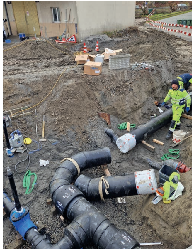
Wasserleitungsbau im Nobengraben, PE 400.
