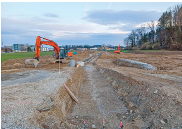
Die Bauarbeiten an der «neuen Stelzstrasse» sind in vollem Gange.
