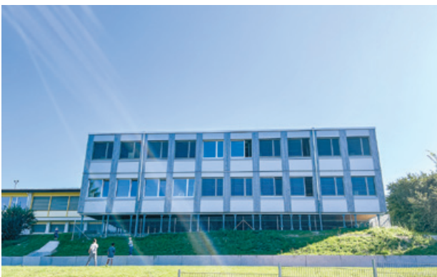
Das Schulraumprovisorium der Primarschule Sonnenhof
