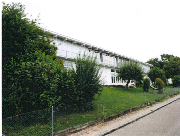
Südansicht Trakt B
