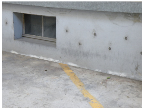
Photo 4 : Trous d'aération de remontées capillaires dans le rez-inférieur de l'entreprise Sbarro
