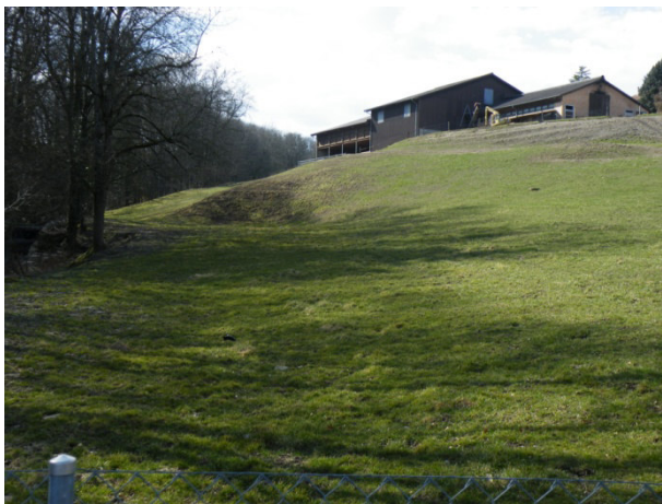
Photo 2 : Pied du glissement nord en rive gauche du Grandsonnet
