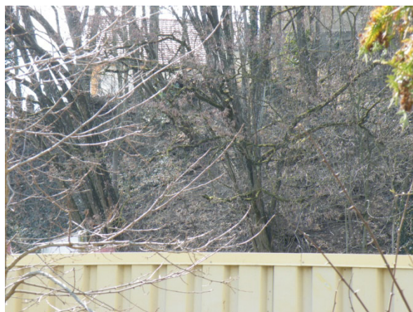
Photo 6 : Versant instable entre la station électrique et l'entreprise Sbarro
