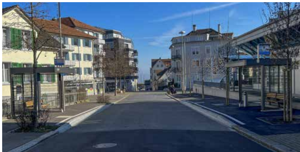
Behindertengerechte Bushaltestelle beim Coop.
