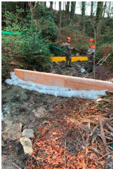
Der Zivilschutz erstellt anlässlich des Hochwassers im 2022 eine Hochwasserschutzbaute.
