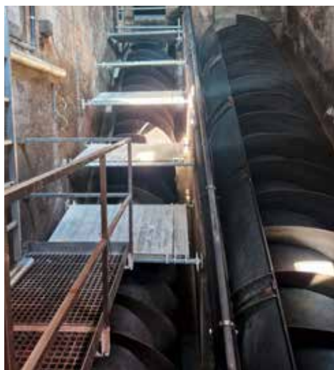
Pumpensumpf Schneckenhebewerk «Drei König».
