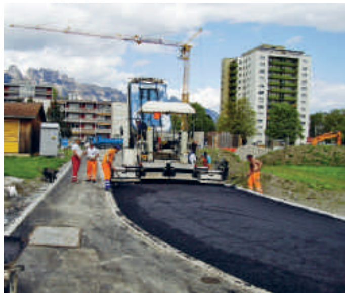
Neubau der Kerbelstrasse.
