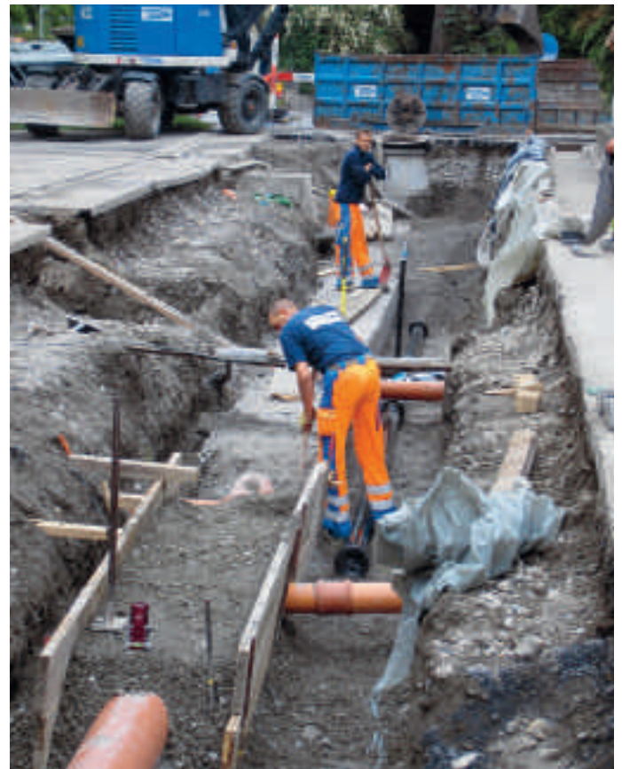
Sanierung einer Abwasserleitung.
